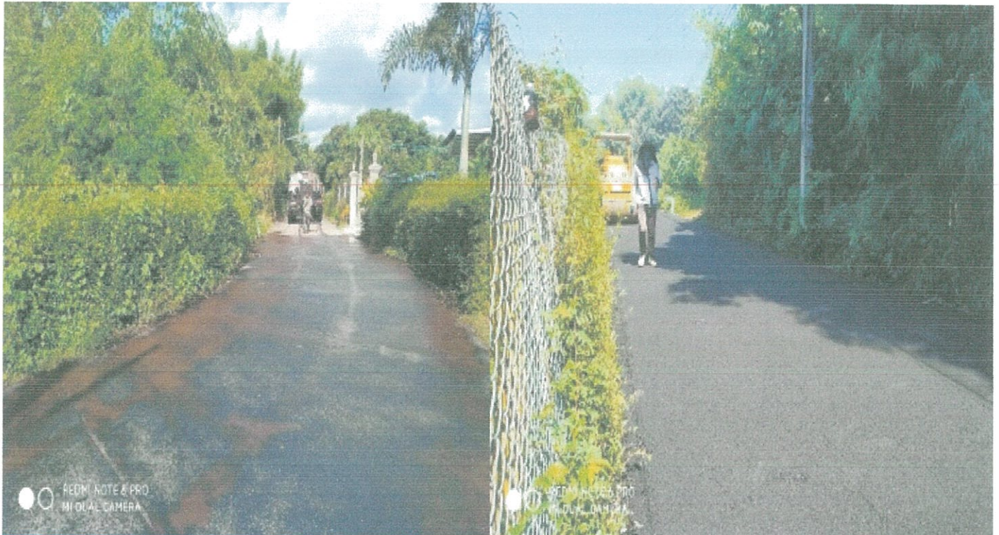
รูปภาพโครงการเสริมผิวทางลาดยางแอสฟัลต์ติกคอนกรีต สถานที่ก่อสร้าง บ้านบ่อควา ( ซอย 5 ) หมู่ที่ 8
