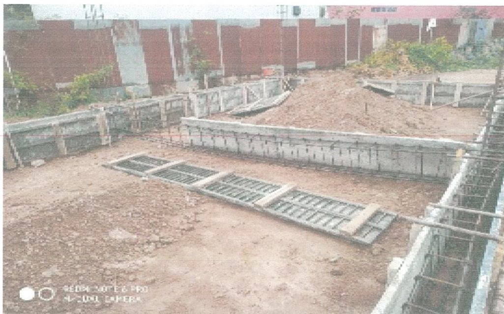
โครงการก่อสร้างอาคารเอนกประสงค์ประจำหมู่บ้าน สถานที่ก่อสร้าง บ้านเหล่าสันปิง หมู่ที่ 5
