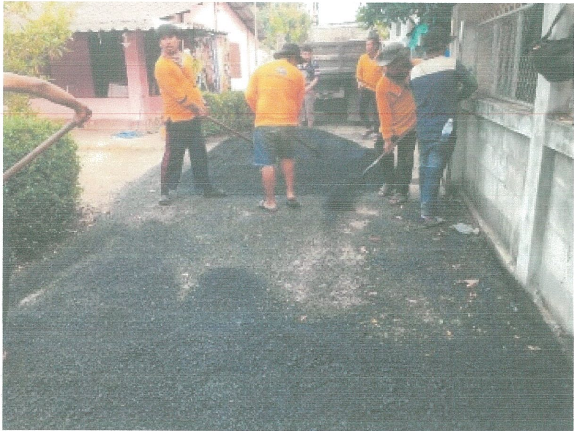
โครงการเสริมผิวทางลาดยางแอสฟัลท์คอนกรีต สถานที่ก่อสร้าง บ้านหนองดู่ หมู่ที่ 1
